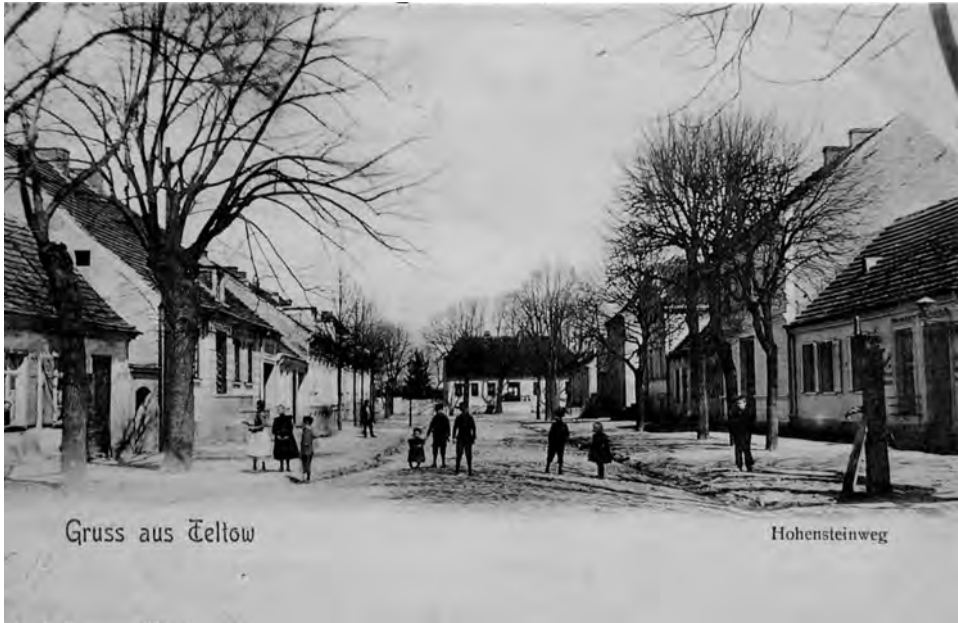
Abb. 8: Hoher Steinweg in Richtung Ecke Ritterstraße, um 1900
